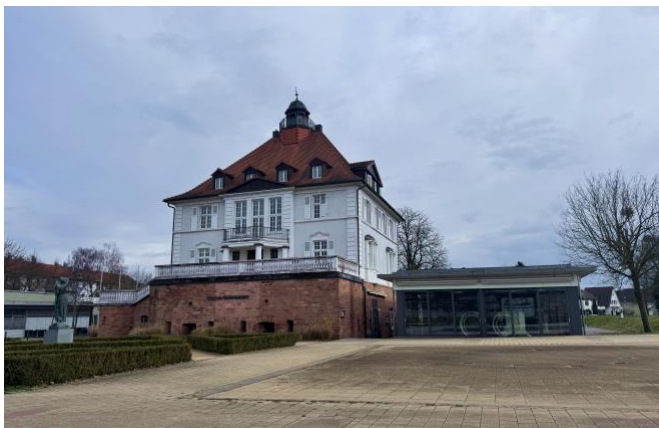
Ansicht Villa Schmidt und Glashaus und Vorplatz
